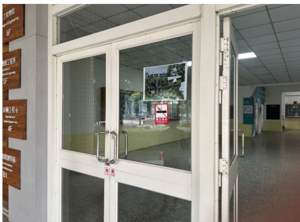
綜三館出入口張貼禁菸標誌
